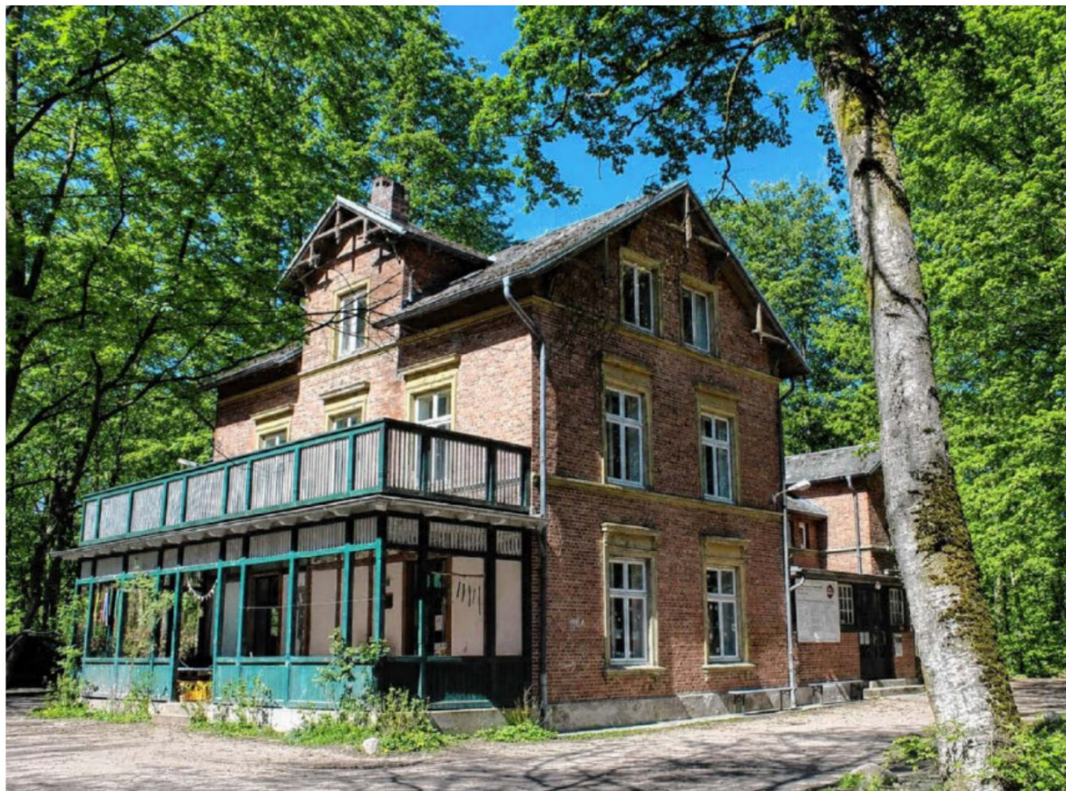
Die Villa Mutzenbecher wurde vor einigen Jahren denkmalgerecht saniert, jetzt bekommt das Haus noch ein neues Dach.
